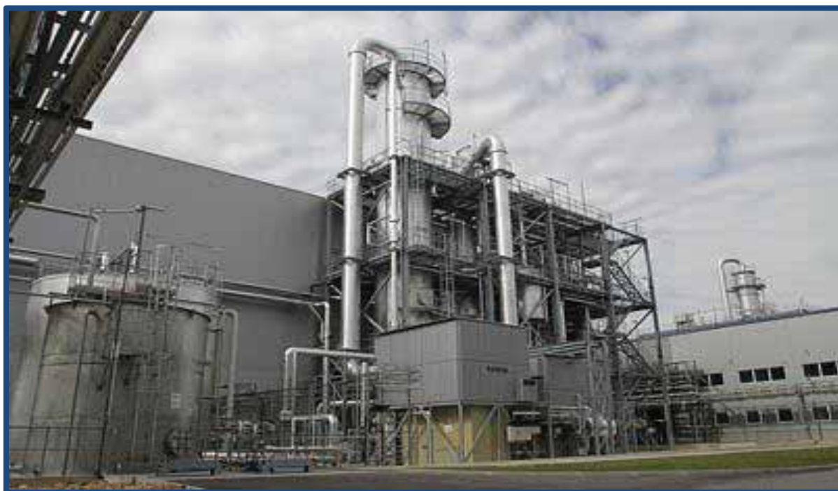
Neutralizační a dekontaminační stanice ve Stráži pod Ralskem Foto: Syner
