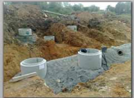
KANALIZACE PŘED ZASYPEM
