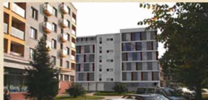
BYTOVÝ DŮM V KOUNECH
