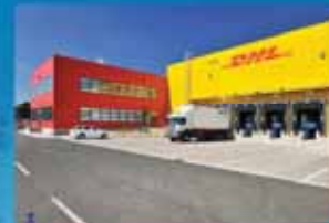
1 DHL (logistické centrum) Hradec Králové projekt 2008 realizace 2009 IN 150 mil. Kč
